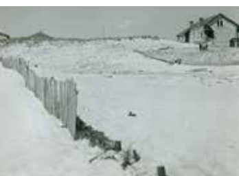
Exemple d'édification d'une palissade en planches (photo : Toulgouat, hiver 1951-1952, Contis)
