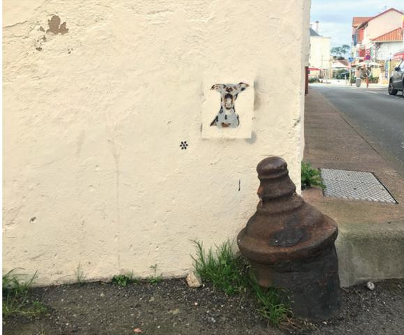
*Une borne charretière, appelé aussi “chasse-roue” est une pièce métallique ou en pierre située au pied d’une porte-cochère ou d’un mur et qui est destinée à empêcher les roues de détériorer le mur. On le désigne également par boute-roue ou bouteroue. Cette borne charretière est un canon retourné. Elle servait autrefois d’appui aux commerçants et paysans pour faire tourner leurs charrettes aux angles des rues. Tu trouveras bientôt une deuxième borne sur ton chemin.*
