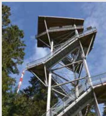
Meymac/Tour du Mont Bessou
