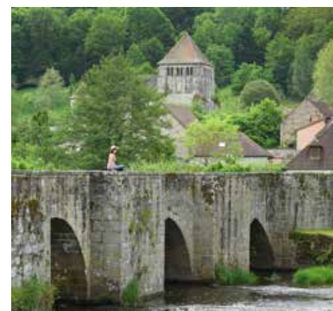
Viaduc de la Tardes
