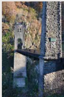
Viaduc des Rochers Noirs
